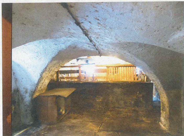
Der ehemalige Stall mit einem wundervollen Gewölbe.
